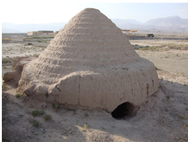
شکل ۴- نمای جنوبی یخچال که یخها را پس از خرد کردن از این قسمت داخل مخزن، انبار میکردند. (بهگوخو، ۱۳۹۰)
